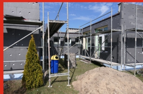
Termomodernizacja Samorządowego Przedszkola w Łochowie. Kwiecień 2021 r.
