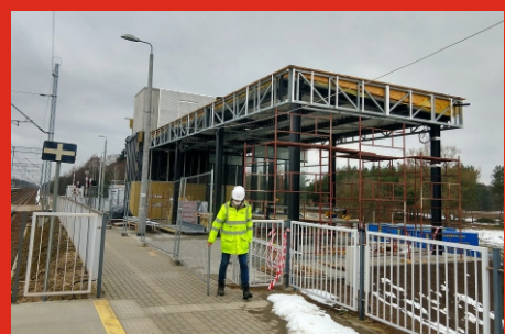
Budowa przystanku kolejowego w Barchowie. Kwiecień 2021 r.
