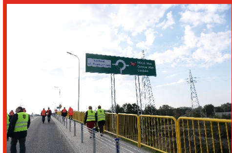
Wiadukt nad torami i DK 50 w miejscowości Jasiorówka. Październik 2021 r.
