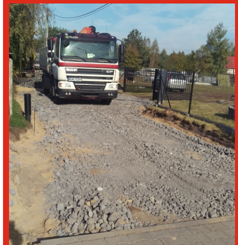
Budziska. Budowa łącznika - zadanie realizowane z Funduszu Sołeckiego.
