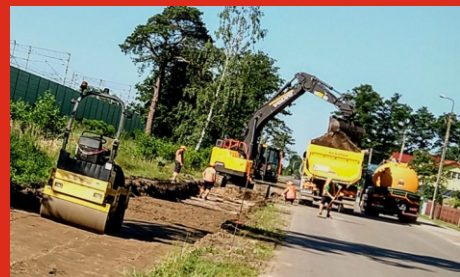
Rozpoczęcie prac przy budowie ścieżki rowerowej wzdłuż ul. Dolnej. Lipiec 2020 r.
