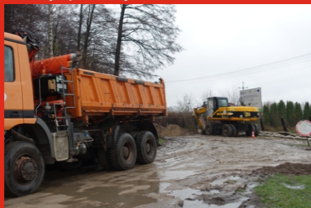
Budowa kanalizacji na ul. Sosnowej w Łochowie
