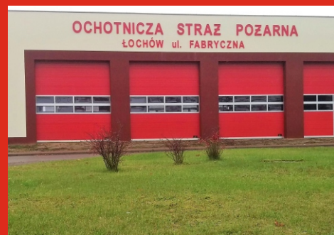
Elewacja garażu OSP Łochów, ul. Fabryczna
