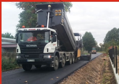
Prace na ul. Dębowej w Gwizdałach
