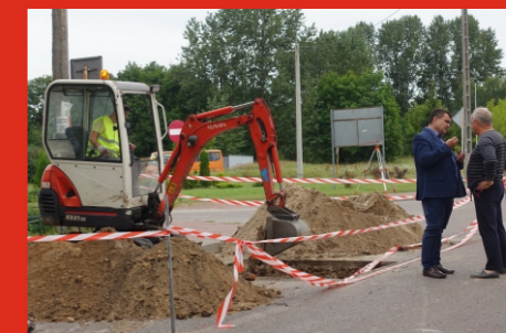
Trwa remont biurowca przy OSP ul. Fabryczna
