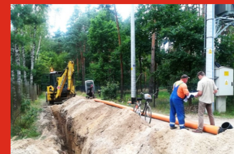
Barchów - rozpoczęcie budowy gazociągu przez SIME
