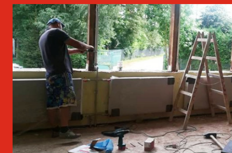
Termomodernizacja Szkoły Podst. Nr 1
