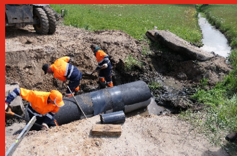
Nowe przepusty na nowobudowanej ul. Lipowej w Gwizdałach. Maj 2022 r.
