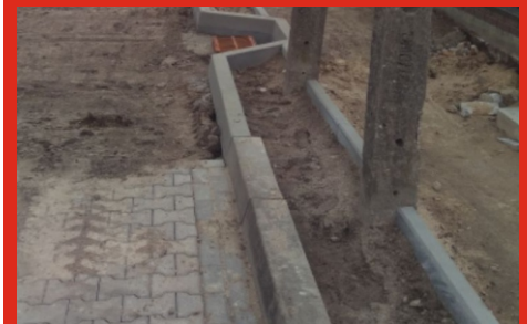
Przebudowa ul. Sadowej w Łochowie.
