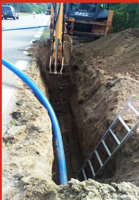
Budowa kanalizacji sanitarnej w ul. Myśliwskiej. Sierpień 2022 r.
