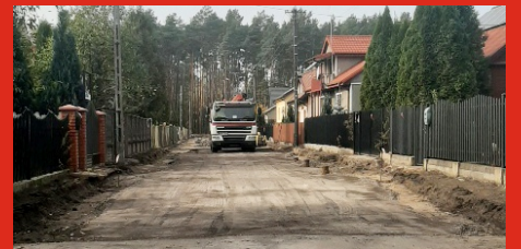
Trwają prace przy przebudowie ul. Leśniej i Zwycięstwa w Ostrówku.
