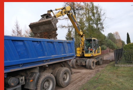
Prace przy przebudowie drogi w Burakowskim. Listopad 2022
