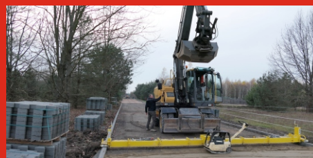
Trwają prace przy przebudowie ul. Leśnej i Zwycięstwa w Ostrówku. Listopad 2022
