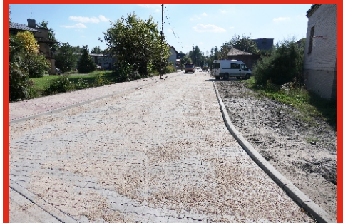
Ulica Modrzewiowa w Łochowie oddana do użytku. Październik 2023.
