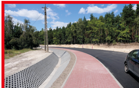
Budowa drogi powiatowej w Łosiewicach z dofinansowaniem z Polskiego Ładu Program Inwestycji Strategicznych. Lipiec 2024 r.
