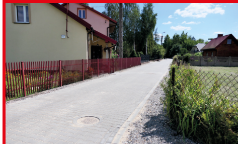
Zakończono budowę ul. Olszowej w Łochowie. Dofinansowanie z Polskiego Ładu. Lipiec 2024 r.
