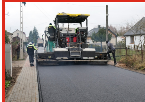
Nowa nawierzchnia drogi w Jasiorówce. Listopad 2025 r.
