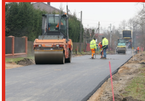
Budowa drogi w Laskach. Listopad 2025 r.
