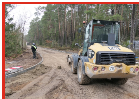
Remont drogi w Szuminie. Listopad 2025 r.
